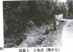
写真3 C地点 (南から)
